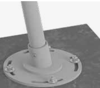
Montage Säule mit Betonanker-Schrauben
